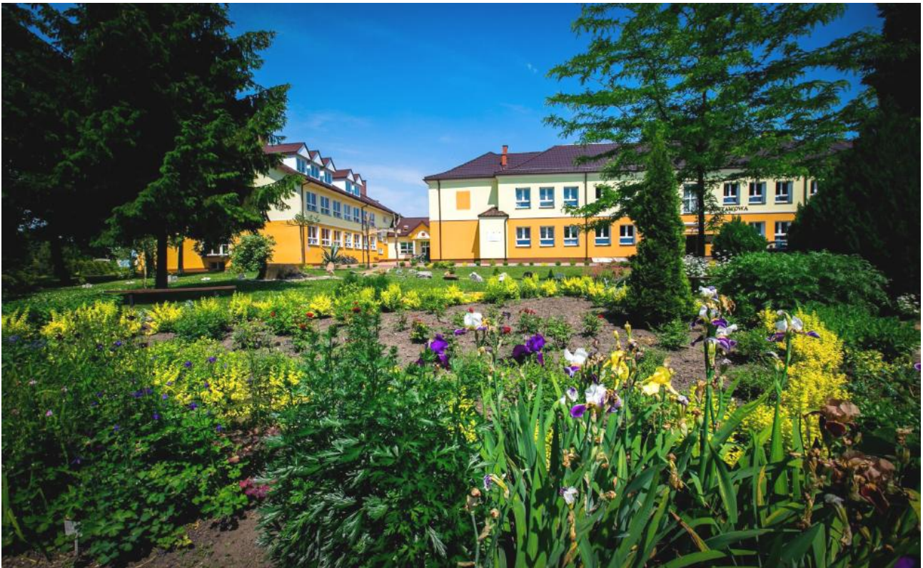
Rysunek 21. Budynek Zespołu Szkół w Mirczu po pracach termomodernizacyjnych i remontowych
