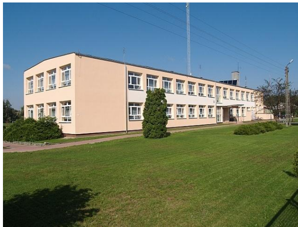
Rysunki 24-25. budynki po termomodernizacji
