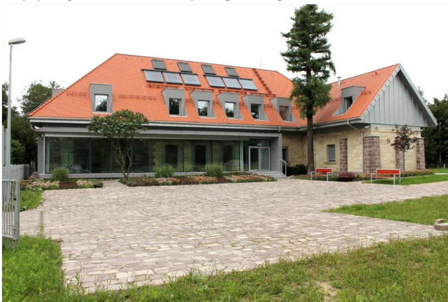
Rysunek 23. Budynek Laboratorium Edukacyjno–Badawczego Odnawialnych Źródeł i Poszanowania Energii WGGIOŚ AGH w Miękinii (stan po modernizacji)
