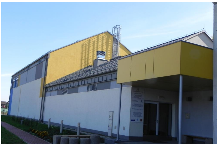
Rys. 28 Sala gimnastyczna przy Zespole Szkół w Waganowicach
