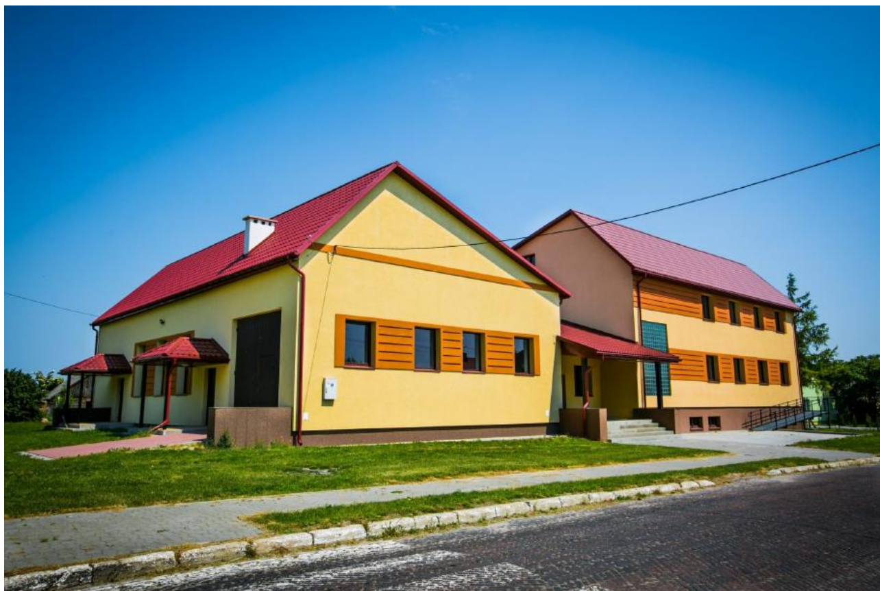
Rysunek 22. Budynek remizo-świetlicy po pracach termomodernizacyjnych i remontowych
